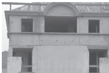
Exemple façade ouverte avec 30% d'ouverture
