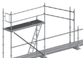
Faire glisser les lisses dans votre main, les fixer sur le montant opposé et fermer les clips
