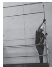
Emboîter le montant sur la structure Le garde-corps est posé.
