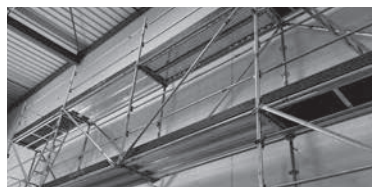
Exemple de franchissement en Uni-Safe en utilisant un montant pour porte-à-faux Uni-Safe 1,16 m
