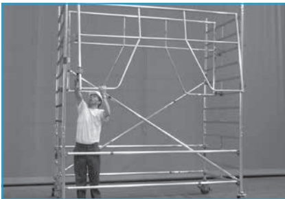
3 - Pose des garde-corps de sécurité définitifs.
