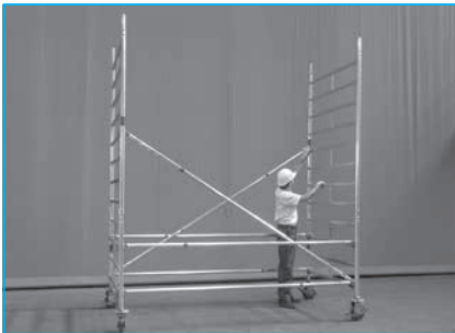
2 - Pose des cadres 8 barreaux puis les diagonales.
