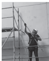
Insérer les 2 lisses dans les clips fermés
