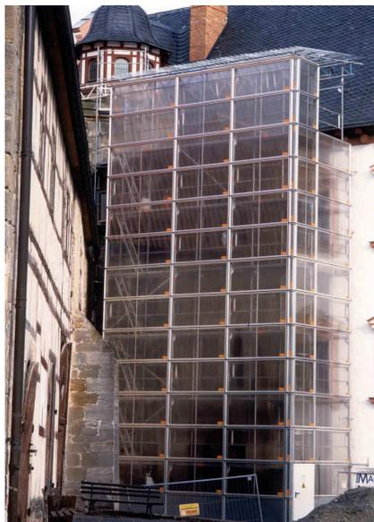
Développé pour s'adapter sur les matériels UNIVERSEL, EUROFACADACIER et EUROFACADALU Layher, chaque caisson mural d'une hauteur de 1m est constitué d'un cadre en aluminium et d'une bordure d'entourage en caoutchouc pour des raccords nets et étanches.
