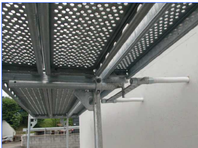
Amarrage ISOL-EX avant la pose de l'isolation extérieure
