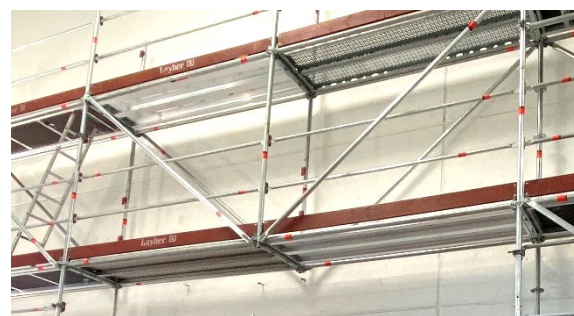
Franchissement en diagonales
