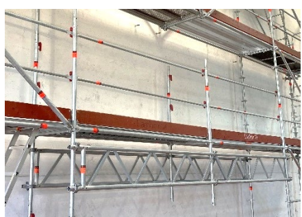
Franchissement avec poutre LW
