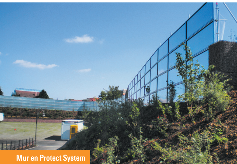
Protection de toiture en Couvralu
