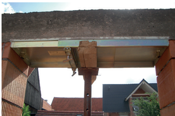
Coffrage de linteau
