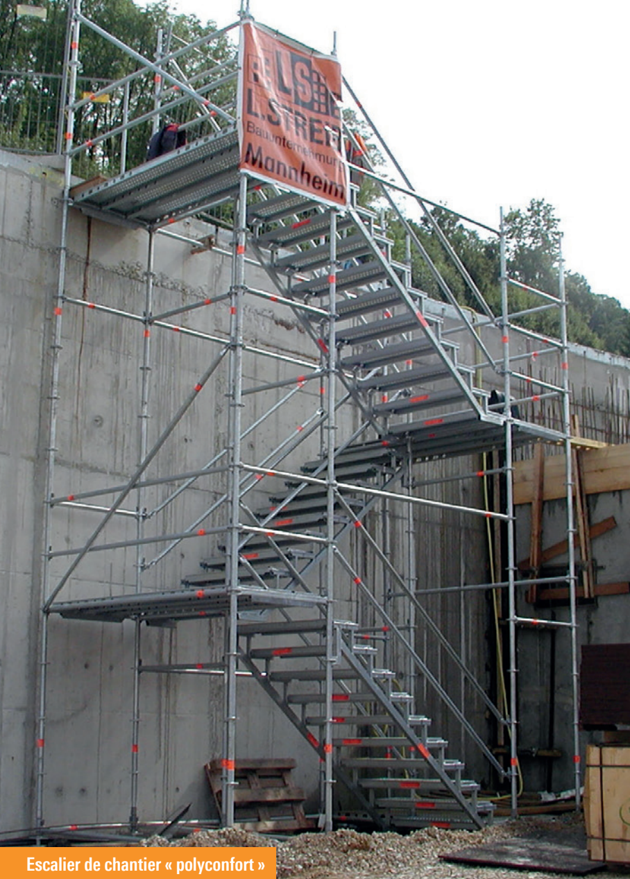
Escalier de chantier « polyconfort »
