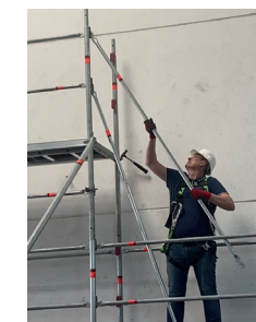
Insérer les 2 lisses dans les clips fermés.
